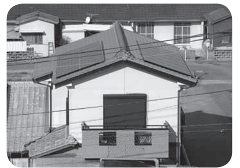
住宅に設置された太陽光発電システム
