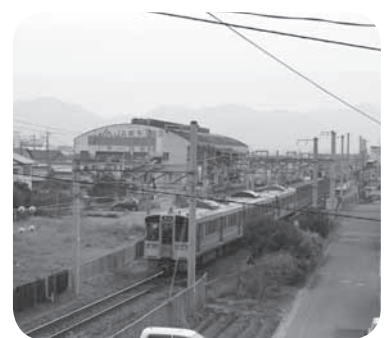
整備を待つ壬生川駅周辺
