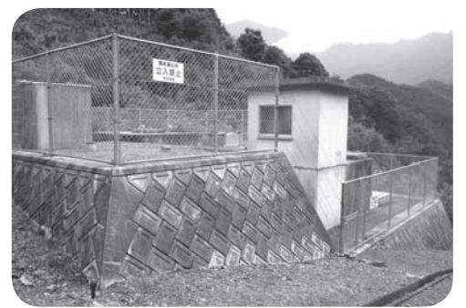
丹原町明河地区の共同給水施設
