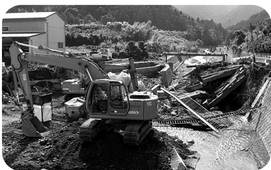
平成16年台風災害時 重機での復旧作業
