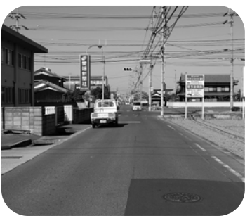
整備が予定される市道壬生川丹原線
