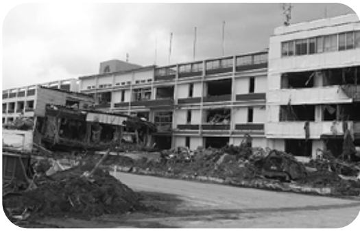
被災した岩手県陸前高田市役所
