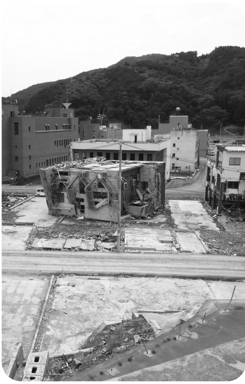
被災した宮城県女川町(平成23年7月現在)
