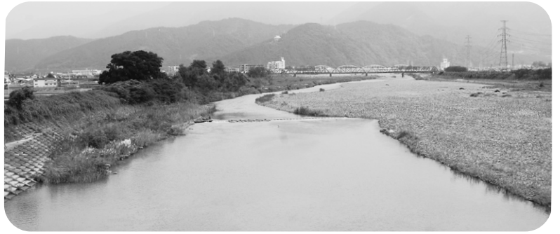
水都橋から見た加茂川
