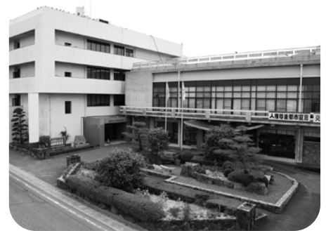
小松総合支所
