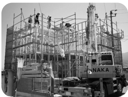
住宅建設現場
