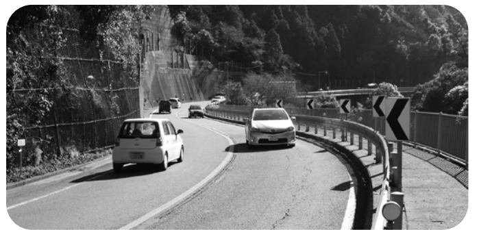
カーブが続く丹原道路
