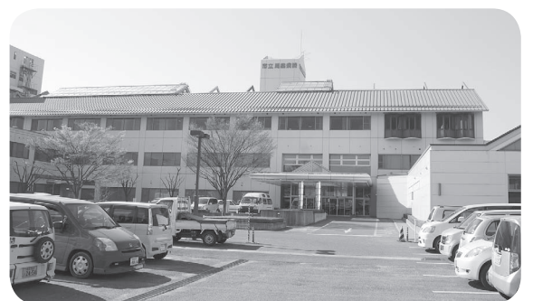
自家発電設備のある西条市立周桑病院
