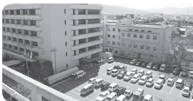
既存本館(左側)と新館建築予定地(駐車場部分)
