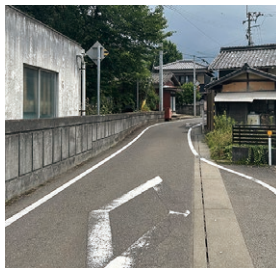
▲市道小松小学校西線 (整備対象の路線)
