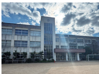
▲改修予定の校舎
