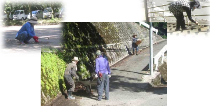
旧鞍瀬小学校スロープもすっきりしました。
