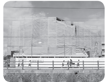
建設中の五百亀記念館
