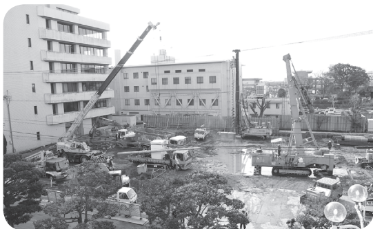
再開された新館建設工事
