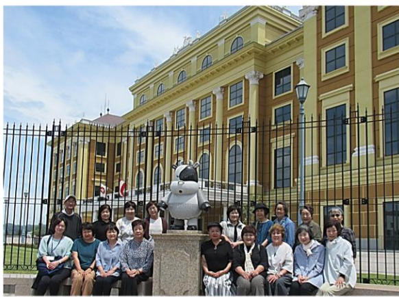
日本食研シェンブルン宮殿工場
