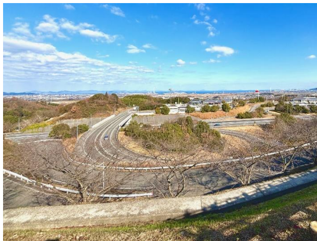
松山自動車道 石鎚SA周辺
