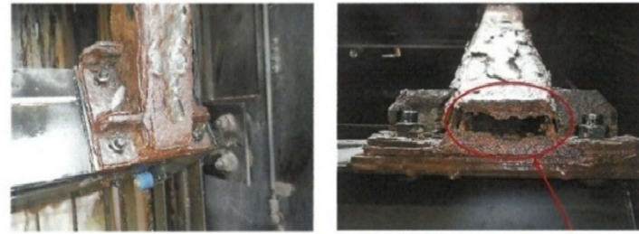
レーキアーム下部 (東側) 穴 老朽化した自動除塵機(干拓ポンプ場)
