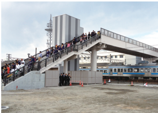
ぼぼ橋（市道伊予西条駅自由通路南北線）開通（平成24年10月）
