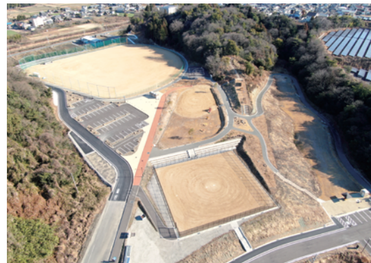
西条東部公園オープン（令和4年3月）
