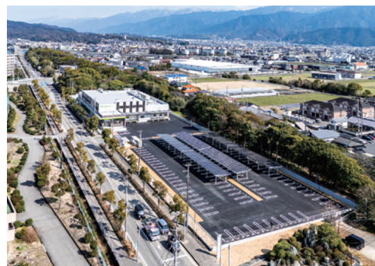
東部学校給食センター完成（令和7年3月）
