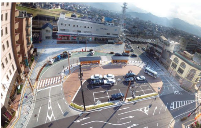
JR伊予西条駅前広場完成 (平成20年10月)
