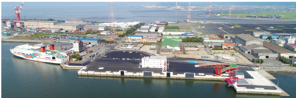
東予港中央地区耐震強化岸壁完成（平成30年7月）
