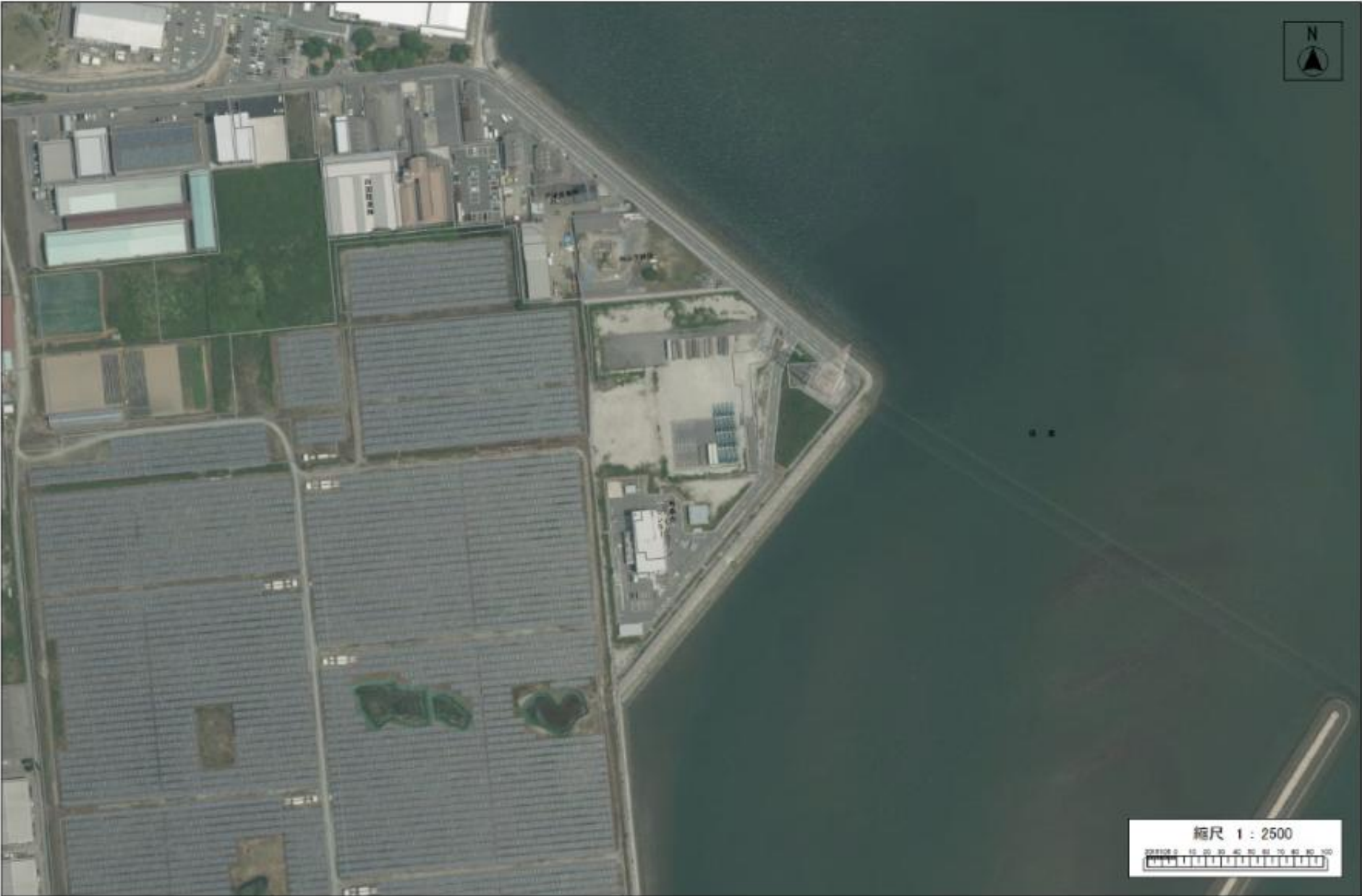
西条市ひうちクリーンセンター④（西条市氷見戊75番地）
