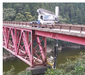
点検車による点検
