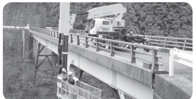
橋りょう点検作業
