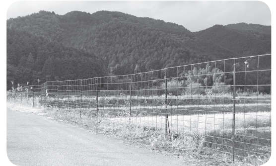
鳥獣被害防止のため設置された防護柵
