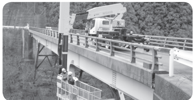
橋りょう点検作業
