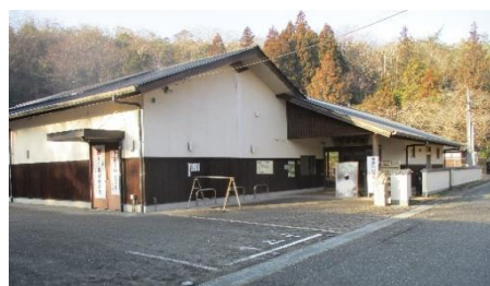
多田銀銅山悠久（ゆうきゅう）の館
