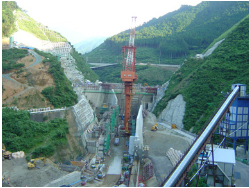
志河川ダム（建設中）
