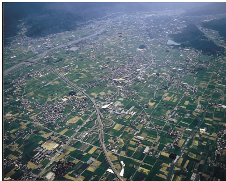
今治小松自動車道(東予丹原インター付近)
