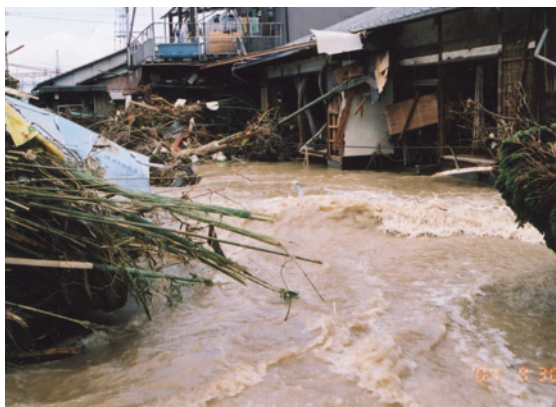
「台風21号」による被害（2004（平成16）年）
