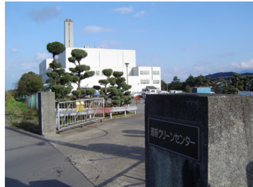
西条市道前クリーンセンター
