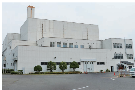
▲老朽化が進んでいる道前クリーンセンター
