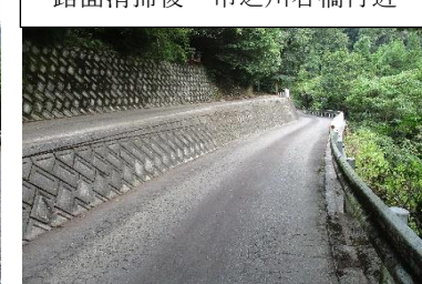
路面清掃後 市之川谷橋付近
