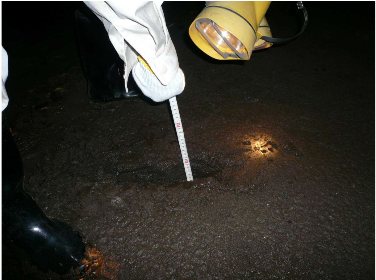
図-27 地下貯留槽に貯まった土砂
