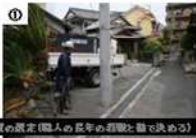
① 掘削の予定(掘削の長年の経験と勘で決める)
