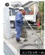
⑧ コンプレッサーのホースを挿入
