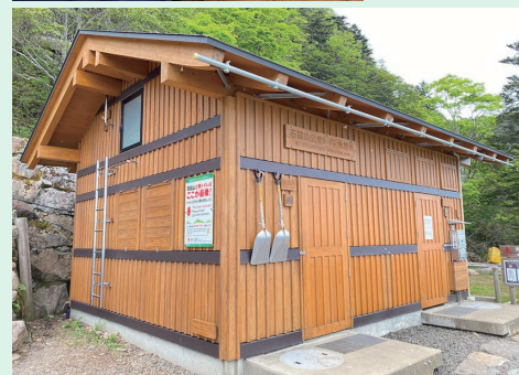
▲昨年、トイレの壁面を塗り替え
