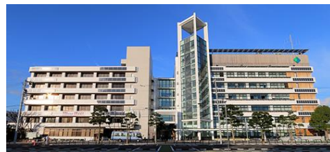
西条市政府 总厅
