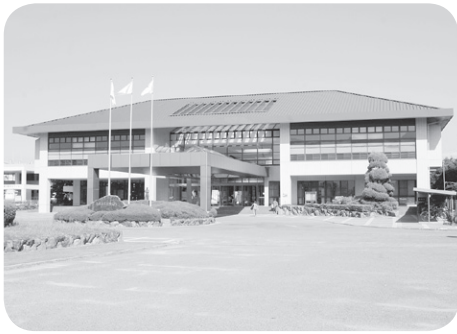
西条市総合体育館
