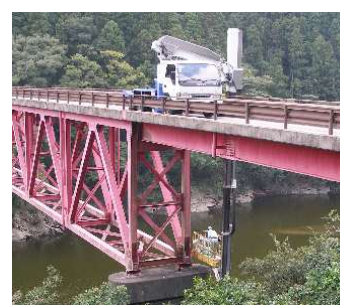
点検車による点検
