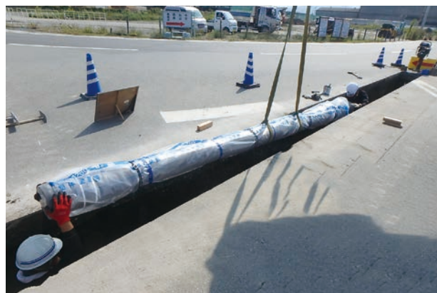
配水管（耐震管）布設状況
