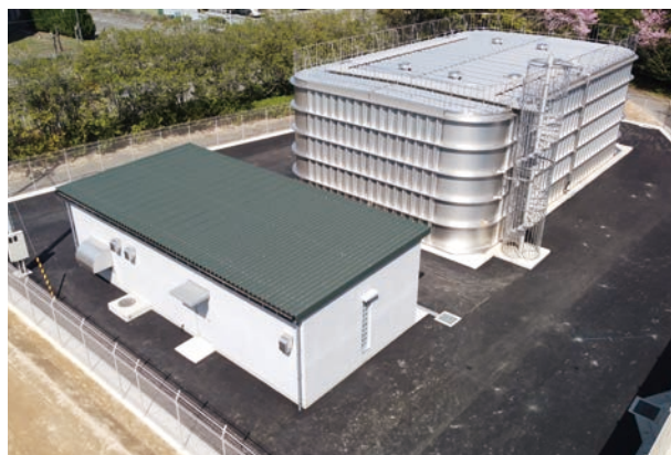
ひうち配水池
