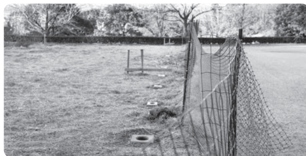
いのしし被害の拡大防止に固定フェンスを設置工事中
