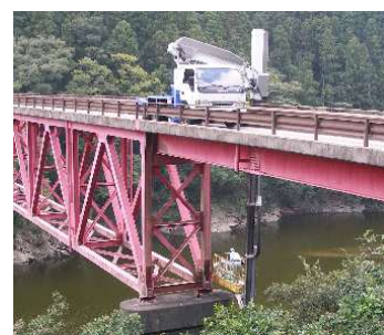
点検車による点検
