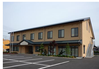
新しくなった大町公民館
