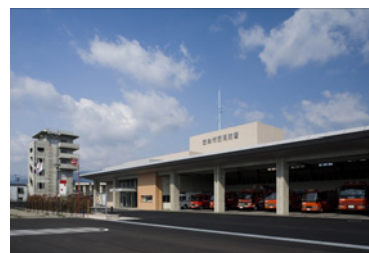
建て替え移転した西消防署
