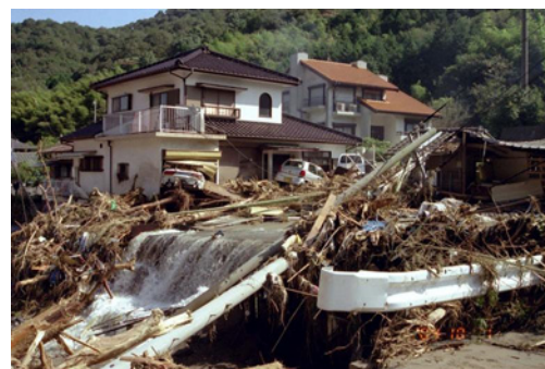
平成16年災害による被害
