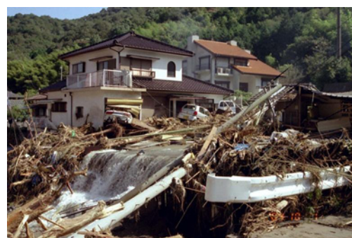
平成16年災害による被害
