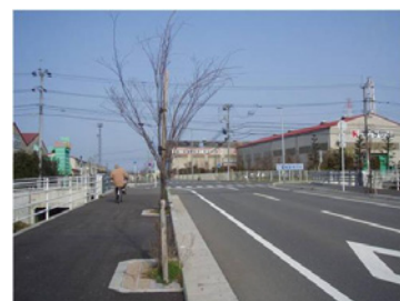
改良が完了した西条駅前干拓地線
