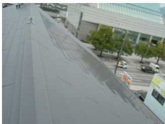
西条図書館の太陽光発電パネル
