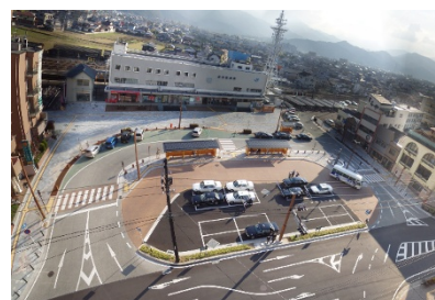
再整備したJR伊予西条駅前
