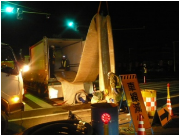
汚水幹線管渠の改築(管更生)工事
