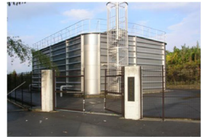
供用を開始した半田山配水池
