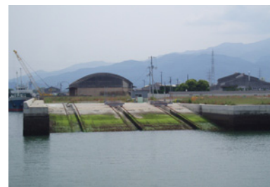
供用を開始した壬生川地区小型船だまり
