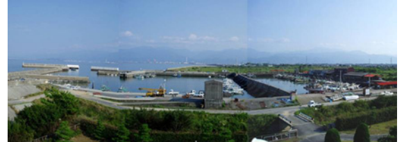
整備が完了した河原津漁港
