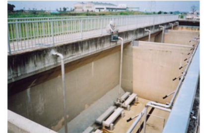
西条浄化センター水処理施設の増設
