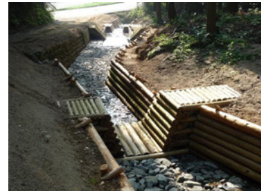
新たに完成した木製ダム
