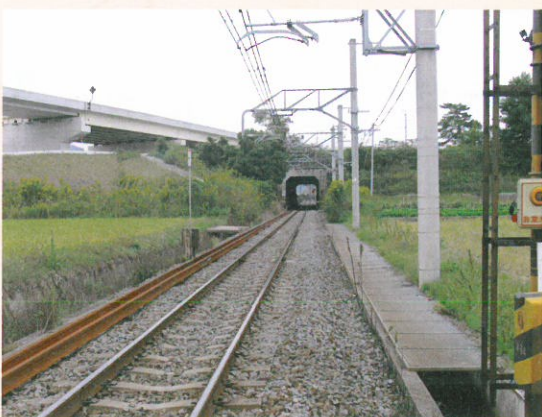
大明神川トンネル
