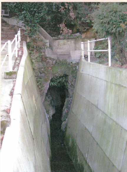
志川掘抜隧道
