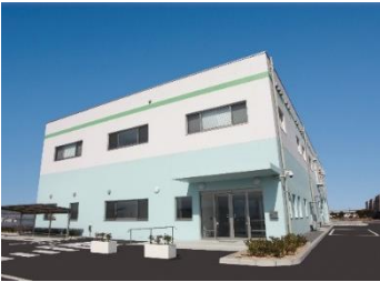
ひうちクリーンセンター整備
