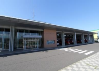
西消防署庁舎建設
