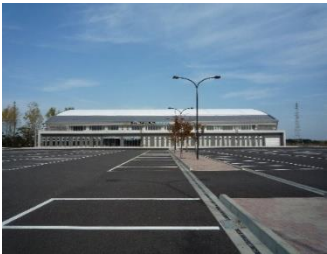
東予運動公園整備
