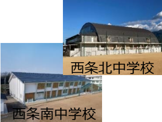
中学校屋内運動場等整備
