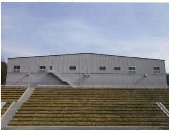
東部一般廃棄物 最終処分場整備
