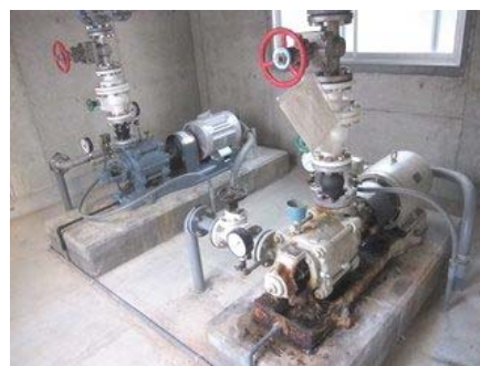
（エネルギー消費の高いポンプ設備の見直し ／水道施設の内、ポンプ設備の電力使用量が多い）
