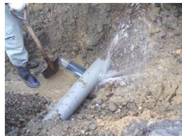
(配水管の破損による漏水)
