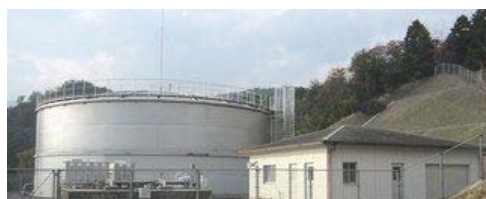
(愛の山低区配水池)
