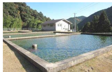
(河之内浄水場の緩速ろ過池)
