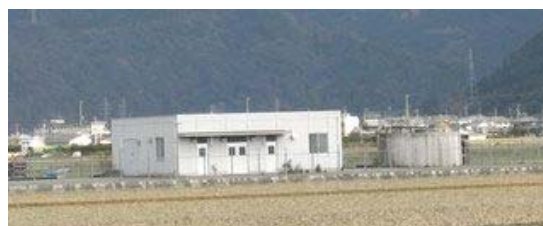
(鍋倉新開水源地)
