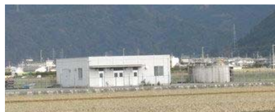
(鍋倉新開水源池)
