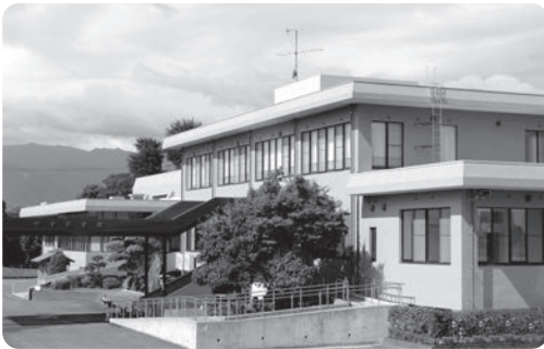
改修工事中のやすらぎ苑
