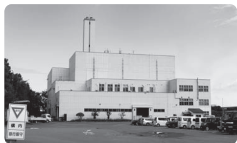
基幹改良工事が進む道前クリーンセンター
